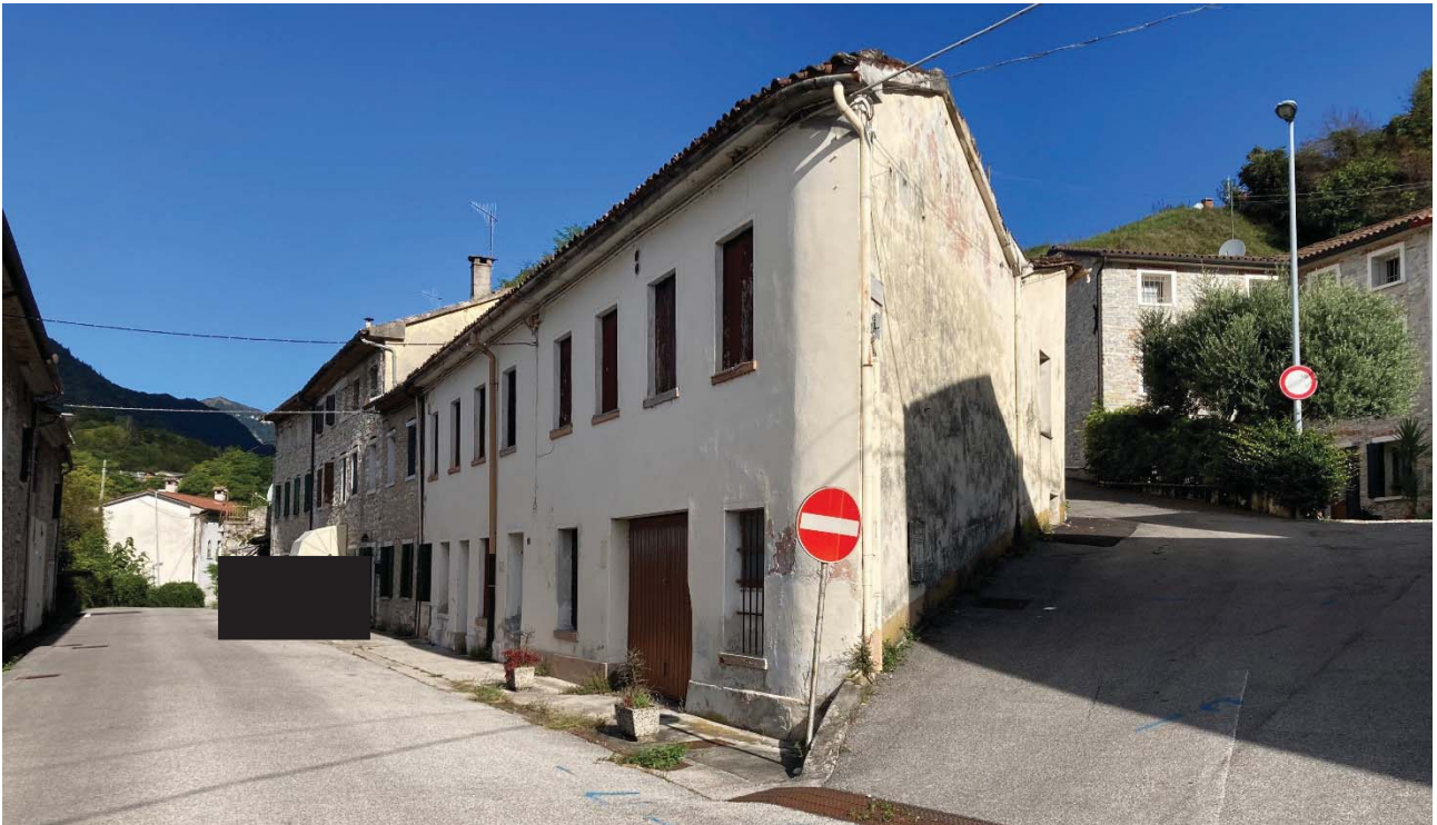
Vista su viale Italia
